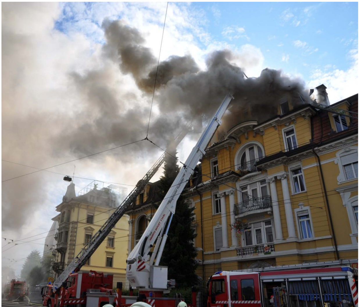
Dachstockbrand Maihofstrasse Luzern, 15. Juni 2013
