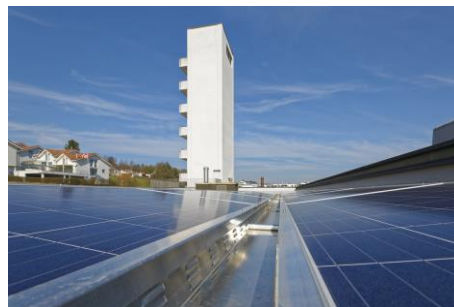
Bild 2: Die auf dem Dach des Feuerwehrzentrums installierte Photovoltaikanlage wird einerseits als Stromlieferant für den Betrieb des Zentrums genutzt und gleichzeitig für die Ausbildung der Feuerwehren eingesetzt
